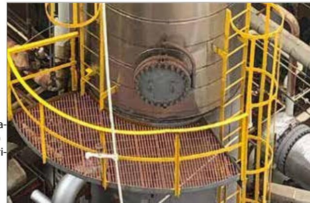
Estas rejillas fueron fáciles y seguras de instalar, sin necesidad de soldadura ni trabajos en caliente. Además, el piso de estas plataformas puede resistir el ambiente altamente corrosivo del aire salino, garantizando una larga vida útil.
